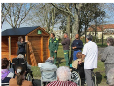
Montage d'un pavillon de 20m3 dans un EHPAD à Nantes
