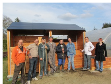
Mise en route d'un pavillon de compostage à la maison de retraite de Tremblay (35)
